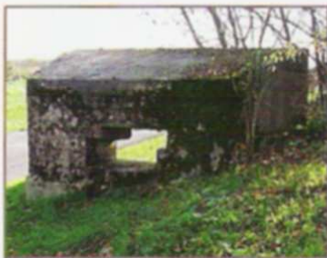
Élément de la ligne Chauvineau, commune de Mont-L'Évêque.
